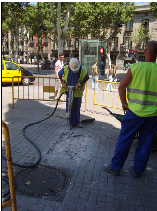
Moment en que s'aixeca el paviment
