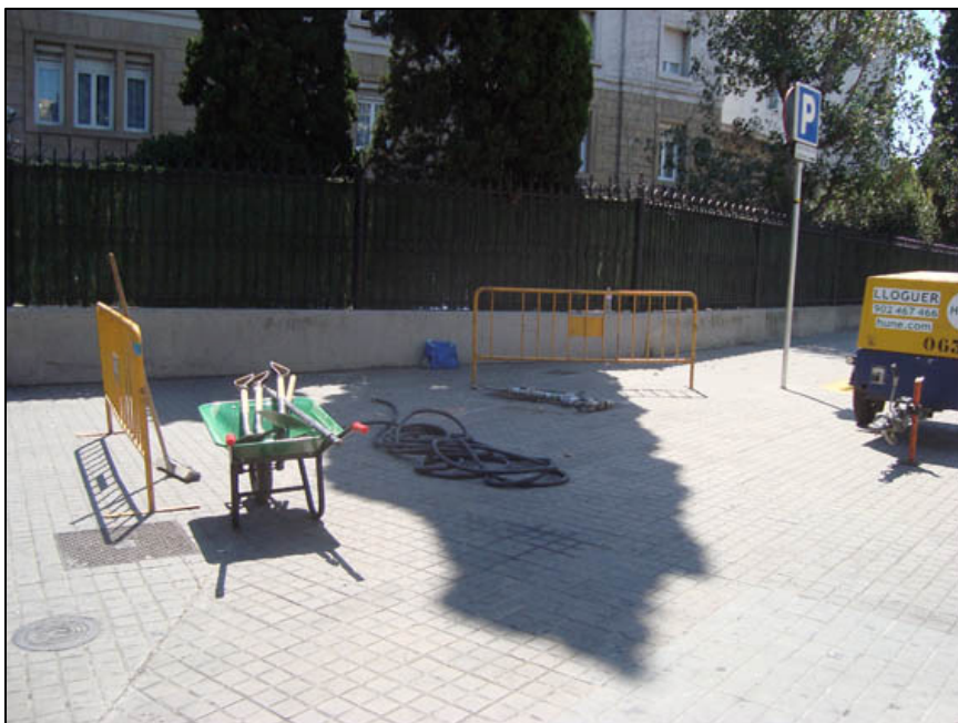
Vista del punt on s'ha realitzat el pou
